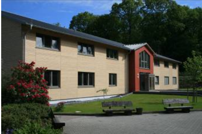
Abb. 35 Das neue Seminargebäude des FBZ. Einweihung Sommer 2008
